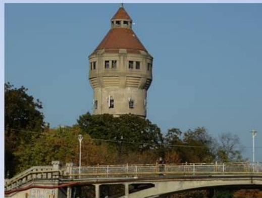
Turnul de Apă din Josefin, construit în 1914, după planurile lui Székely László. Are 52 m înălțime. Rolul său a fost acela de a compensa consumul maxim de apă al orașului în perioada interbelică. Are un "corespondent" mai mare în Fabric, construit în 1912. În stânga se observă și Pasarela pietonală Gelu (1949).
