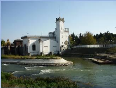
Uzina de Apă (Hidrocentrala), construită după planurile lui Székely László, a fost pusă în funcțiune la 3 mai 1910. Are în dotare turbine Ganz, de 600 CP, care sunt și azi funcționale.
